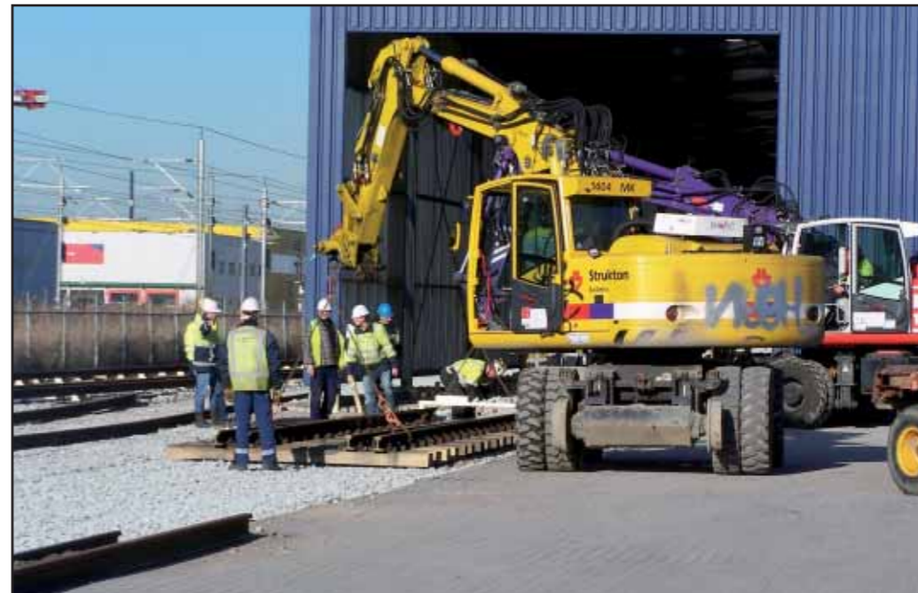
Het eerste wissel wordt met twee kranen op zijn plaats gelegd!
