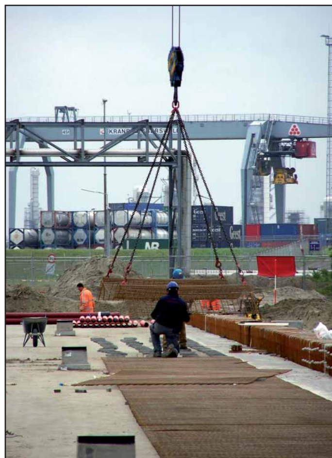
De bouw van de terminal is in volle gang.
