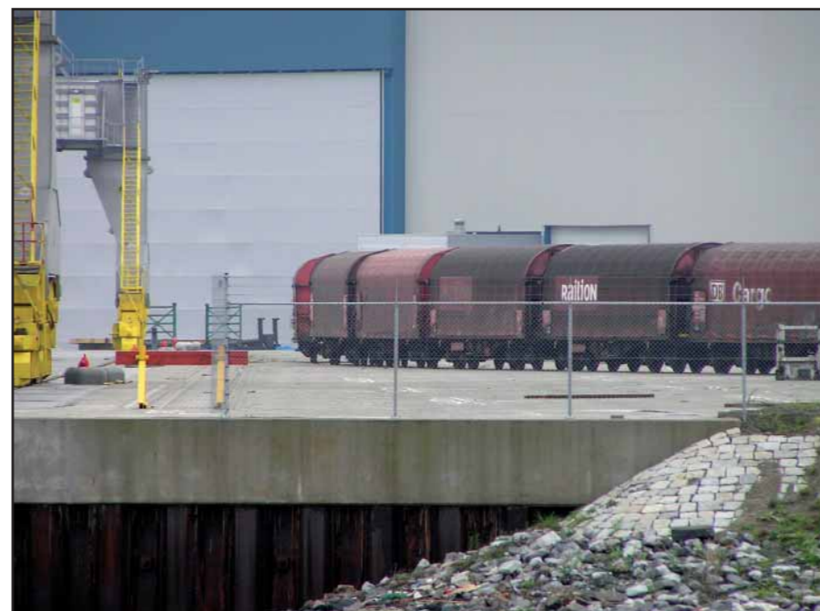
Bedrijfsspooraansluiting Gevelco Britanniëhaven Rotterdam.
