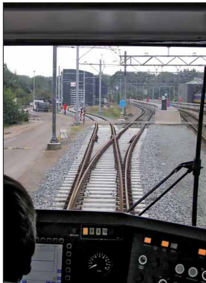
Zicht op de spooraansluiting en werkplaats vanuit de 'Protos'.
