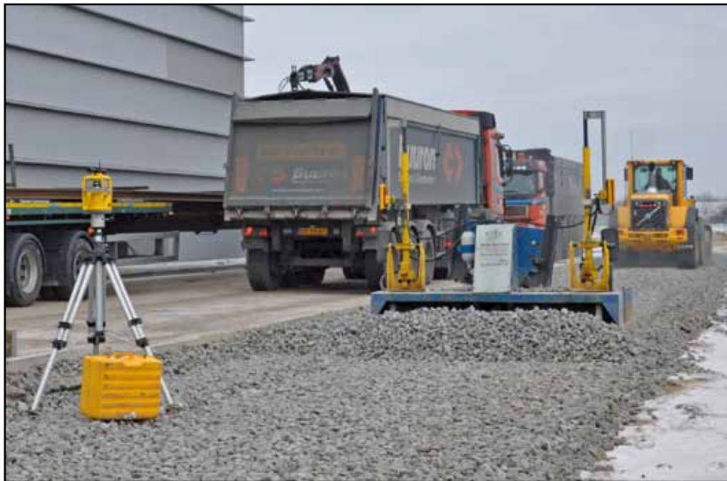
Machinaal aanbrengen van de ballast
